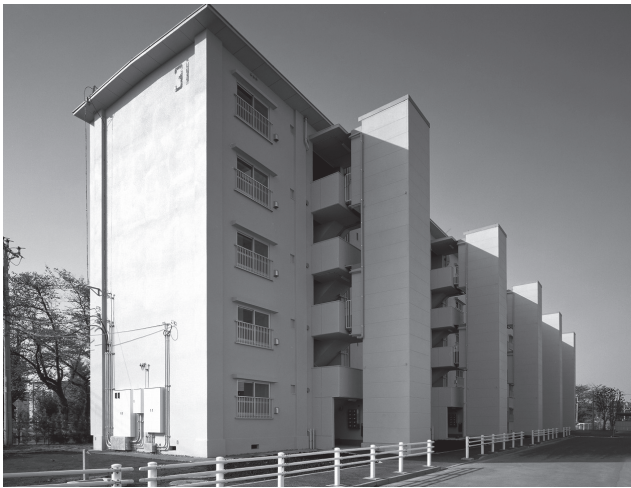
▲後付けエレベーターの例
